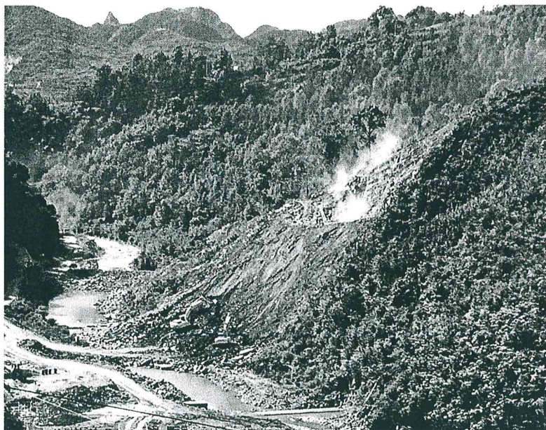
西秀区中型水库新场河坝肩开挖
